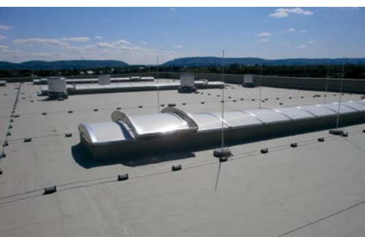
Neubau: ca. 7.000 m 2 Dachfläche mit Flüssigkunststoff abgedichtet, inkl. Wärmedämmung und Einbau der Lichtbänder
