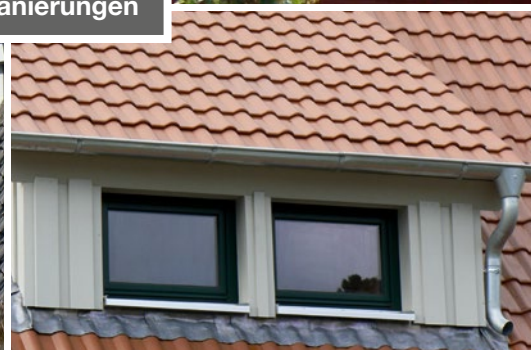
mit Lärchenholz und Zinkentwässerung
