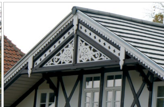
Sanierung eines denkmalgeschützten Einfamilienhauses: Eindeckung mit einem Glatzziegel und Entwässerung aus Zink
