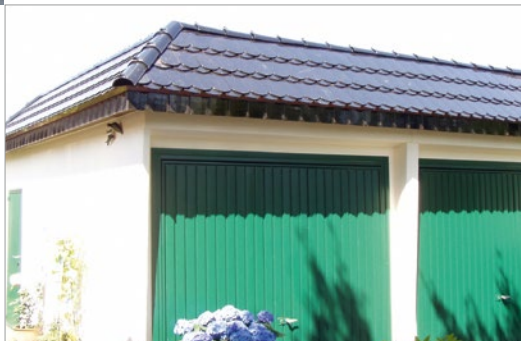
Dachblendenbau auf einer Fertig- garage mit Bieberschwanzziegeln in Kronendeckung
