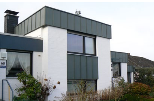
Flachdachsanierung: mit Zinkscharenblenden in Schiefergrau
