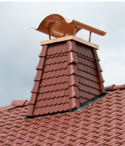
mit Bieberschwanzziegeln und Kupferhaube
