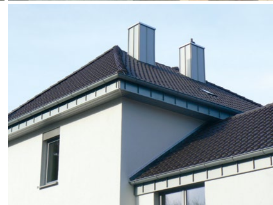
Sanierung Zweifamilienhaus: Eindeckung mit braunengobiertem Hohlfalzziegel, Schornsteine und Blende aus Zinkscharen
