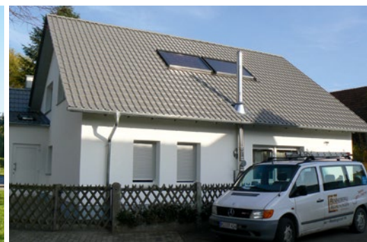
Sanierung Einfamilienhaus: Eindeckung der Dachfläche mit glasiertem Flachdachziegel als Sonderfarbe, Solarthermieanlage für Warmwasser und Dachent- wässerung aus Zink
