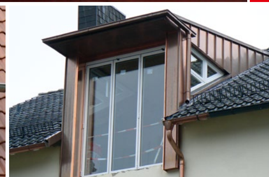
mit Kupferscharen und Kupferentwässerung
