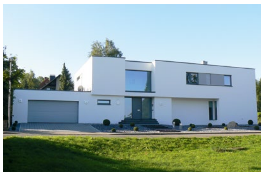
Neubau: Moderne Flachdachabdichtung und Mauerabdeckung aus Aluminium
