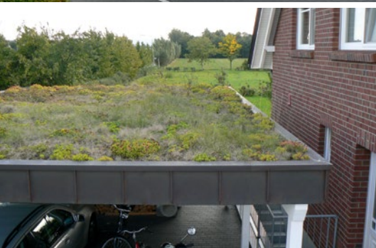
Carportbau, Dachbegrünung und eine Blende aus Kupferscharen
