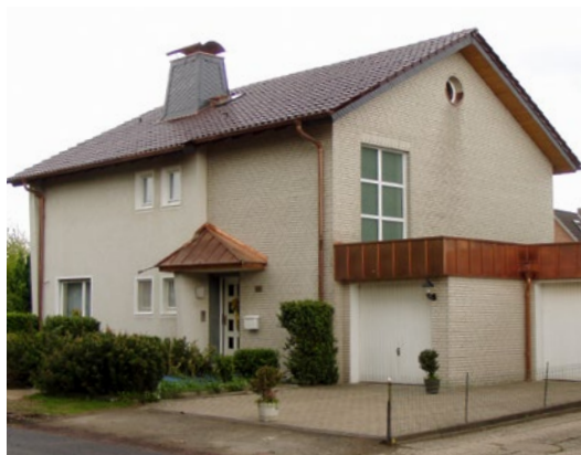
Sanierung Einfamilienhaus: Eindeckung mit glasierten Hohlfalz- ziegeln, Kupferscharen an der Eingangsüberdachung und an der Garagenblende und Schornstein- bekleidung aus Naturschiefer
