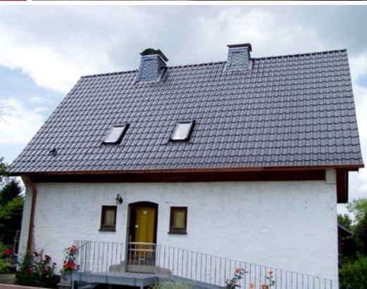
Sanierung Einfamilienhaus: Eindeckung mit glasierten Flachdach- ziegeln, Entwässerung aus Kupfer und Schornsteinbekleidung aus Naturschiefer
