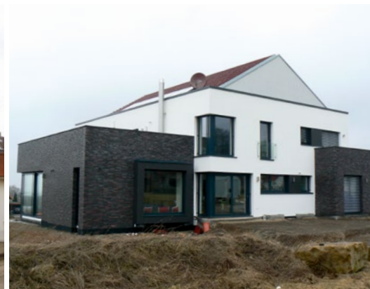
Neubau: Eindeckung mit Glattziegeln und umlaufendem Flachdach, Fenstereinfassungen mit Faser- zement-Elementen und innen- liegender Dachentwässerung
