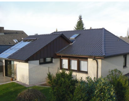
Sanierung Einfamilienhaus: Eindeckung mit schwarzen Flachdach- ziegeln und Kupferscharen inkl. Kupfer- Entwässerung
