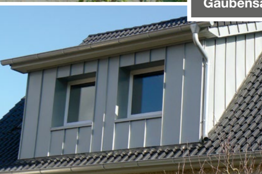
mit Zinkstehfalz vorbewittert und Zinkentwässerung
