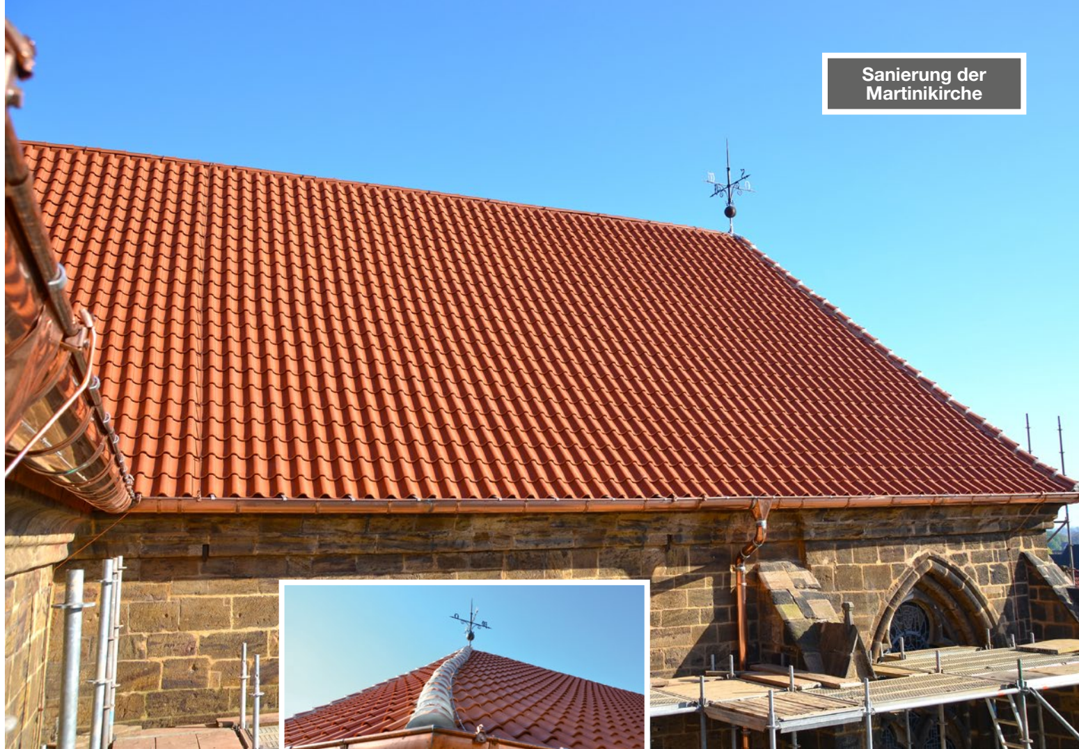
Dachsanierung der denkmalgeschützten Martinikirche.
